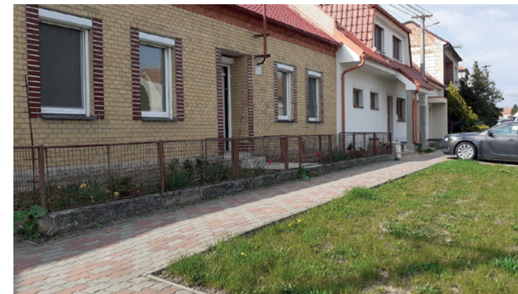
Obr. 81. Původní stav - travnatá plocha.
